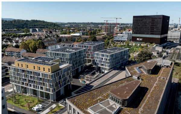
Vue aérienne du complexe avec installations photovoltaïques sur les toits
