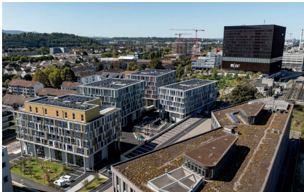
Luftaufnahme der Überbauung mit Photovoltaikanlagen auf den Dächern
