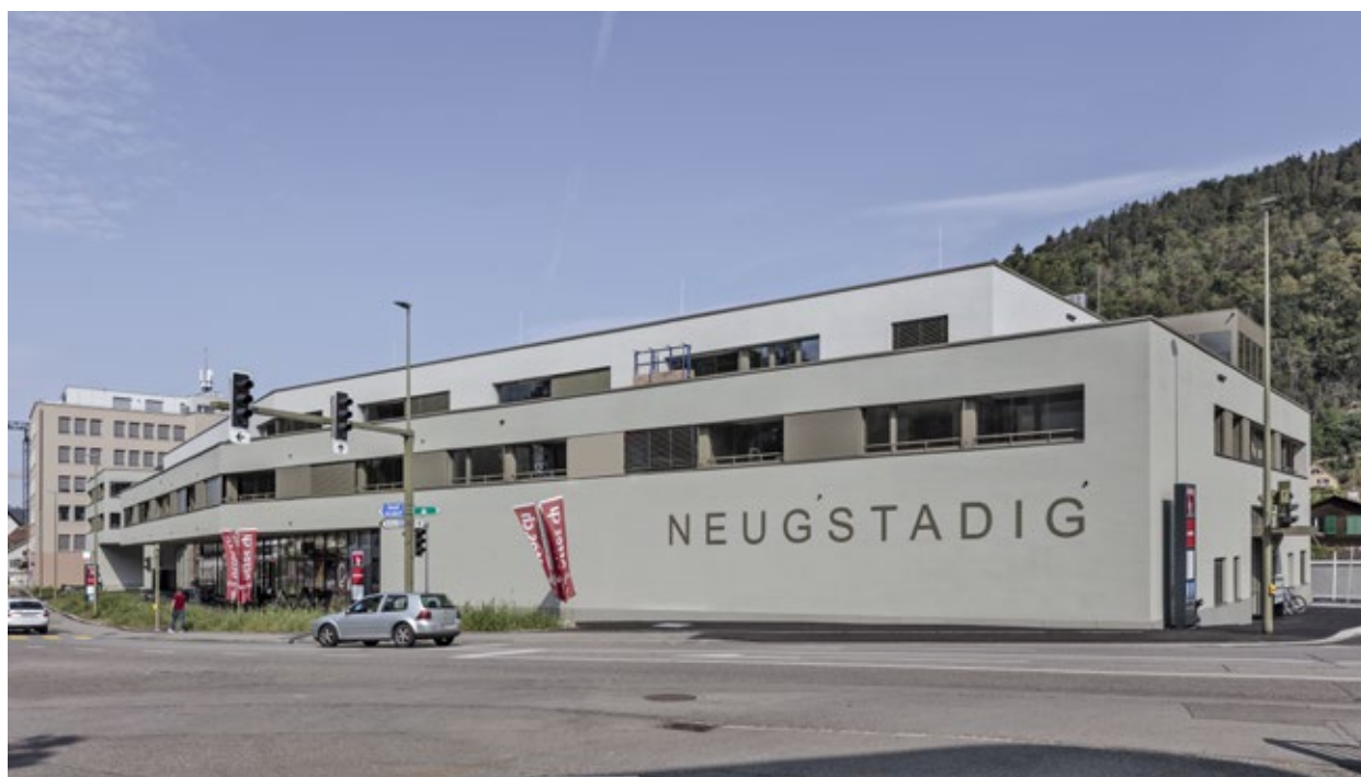
Prise de vue depuis le Nonnenbodenweg, après achèvement
