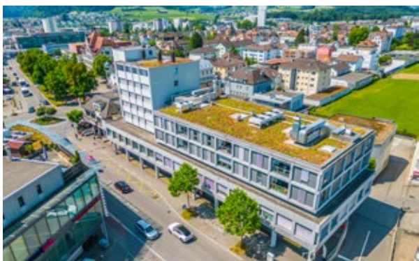
Vue aérienne de l'immeuble de Wil
