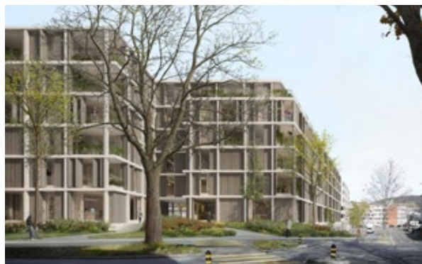
Vue de l'extérieur
