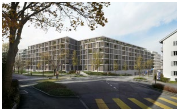
Vue de l'extérieur
