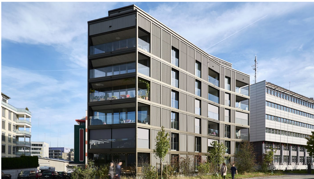
Tribsche 1 Punkthaus, vue de la Tribschenstrasse
