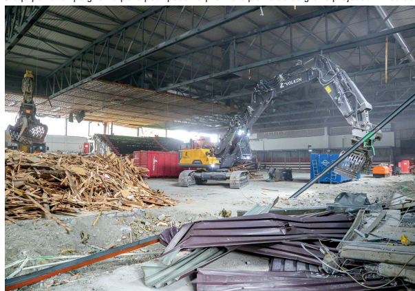
Déconstruction de l'ancienne halle
