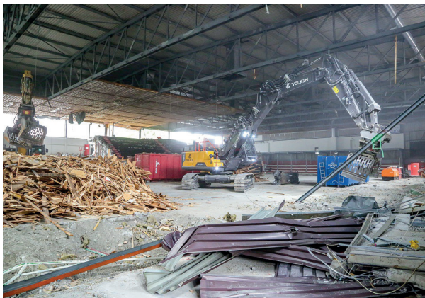
Rückbau der alten Halle
