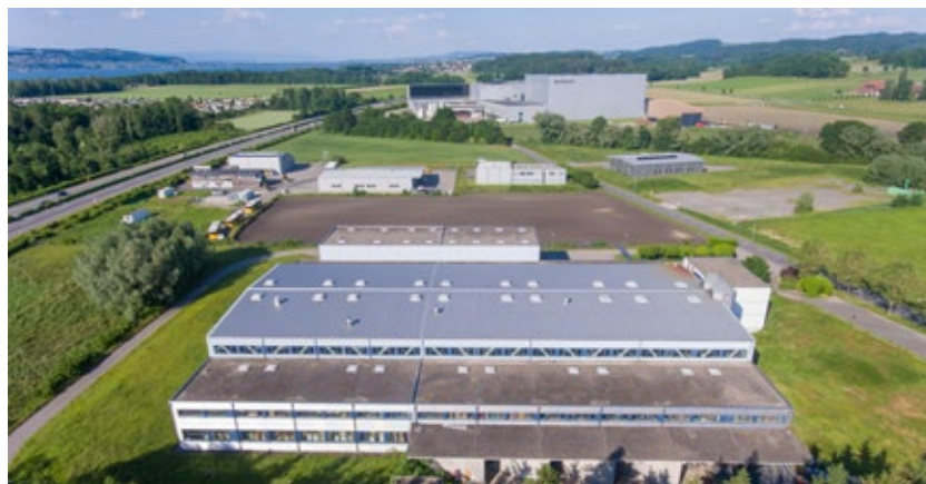
Halle de logistique à Avenches
