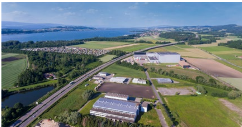
Vue d'oiseau de la halle de logistique
