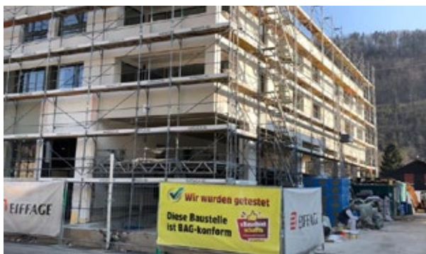
Chantier «Neugstadig» aux normes de l'OFSP
