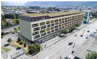
Vue du sud-ouest
