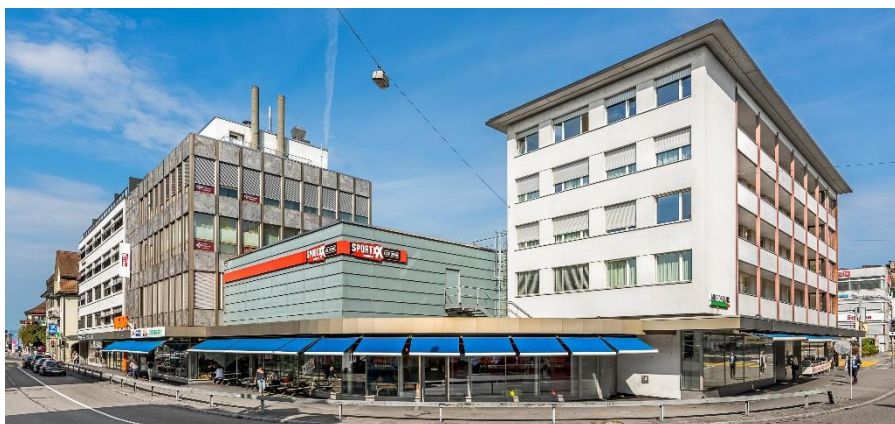
Untere Bahnhofstrasse, 8640 Rapperswil-Jona SG
