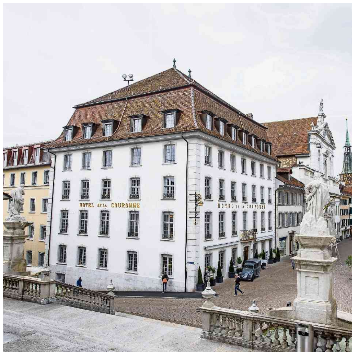
Die neu weisse Fassade soll die Brüstungen und Eckquader aus Solothurner Stein besser zur Geltung bringen. Neu hebt sich der cremefarbige Leist-Flügel im Süden vom barocken Haupttrakt aus dem Jahr 1772 ab.
